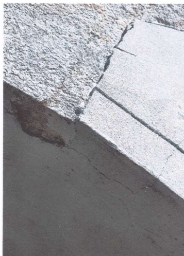
Widoczne warstwy starych wypraw tynkarskich i śladowe ilości XVIIw. wymalowań elewacji wieży .
