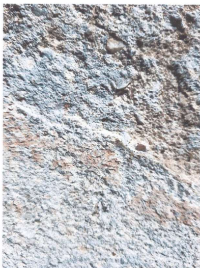
Widoczne warstwy starych wypraw tynkarskich i śladowe ilości XVIIw. wymalowań elewacji wieży .
